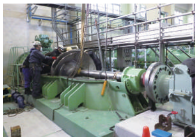
ポンプの現地整備
