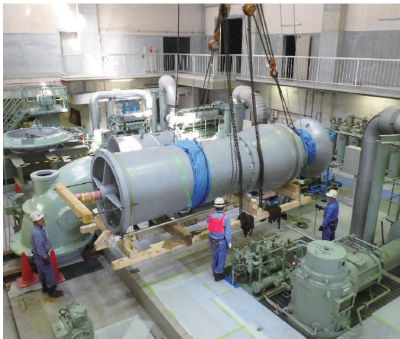
ポンプの搬入
