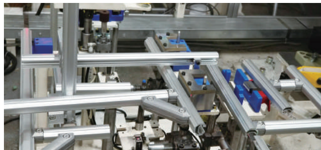
施工事例(検査用治具設置工事)
