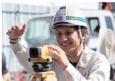
土木現場での測量
