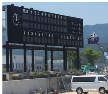
宮古運動公園野球場スコアボード(フッ素焼付塗装)
