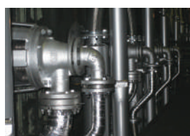
顧客設備に取り付けられたロータリージョイント②
