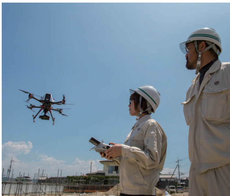
ドローンによる建築現場履行状況撮影
