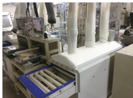
施工事例(熱交換冷却装置改造工事)
