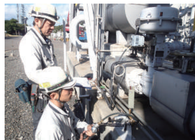
プラント計装設備点検中
