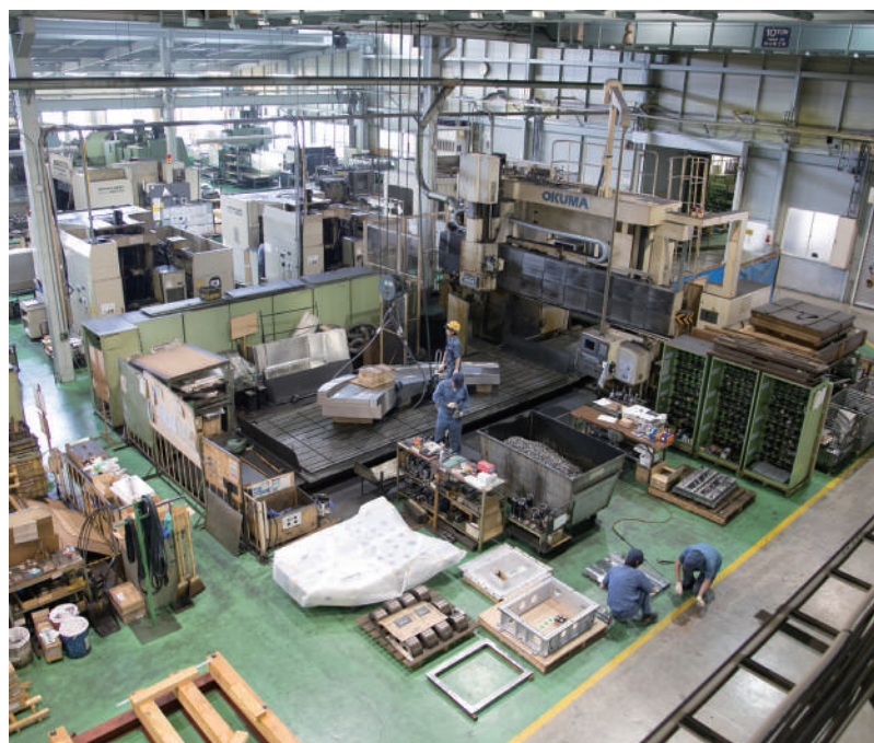
LED化が完了し、明るくなった工場内
