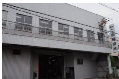
本社外観と作業風景
