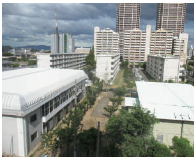
大阪刑務所体育館&amp;道場塗装完了後全景
